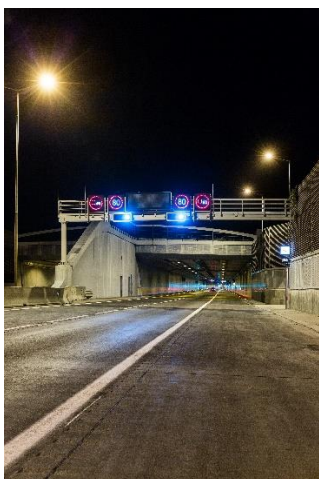
Tunnel Kreuzenstein – Richtungsfahrbahn Korneuburg Downloadlink
