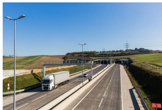
Tunnel Tradenberg – Blickrichtung Vösendorf Downloadlink
