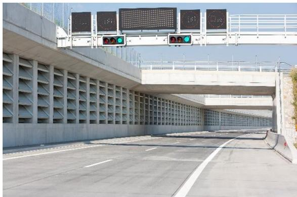
Langlebige Materialien: Der Bonaventura-Autobahnabschnitt wurde bewusst als Betonfahrbahn errichtet. Durch die längere Lebensdauer braucht die Fahrbahn weniger Erneuerungszyklen und damit auch weniger Material. Aufgrund der helleren Farbe heizt sie sich auch weniger auf als Asphalt, was in Zukunft in der Klimazone des Weinviertels ein zu berücksichtigender Faktor werden wird.
