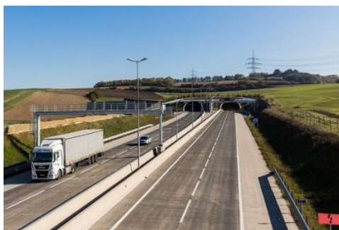
Herbstputz im Tunnel Tradenberg an der A5/S1 © Bonaventura/ Petra Rautenstrauch
