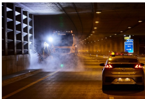
Bei der zweimal jährlich stattfindenden Tunnelwäsche erfolgt eine gründliche Reinigung sowie die technische Wartung der Beleuchtungs- und Lüftungsanlagen. © Bonaventura/ Bernd Geppert
